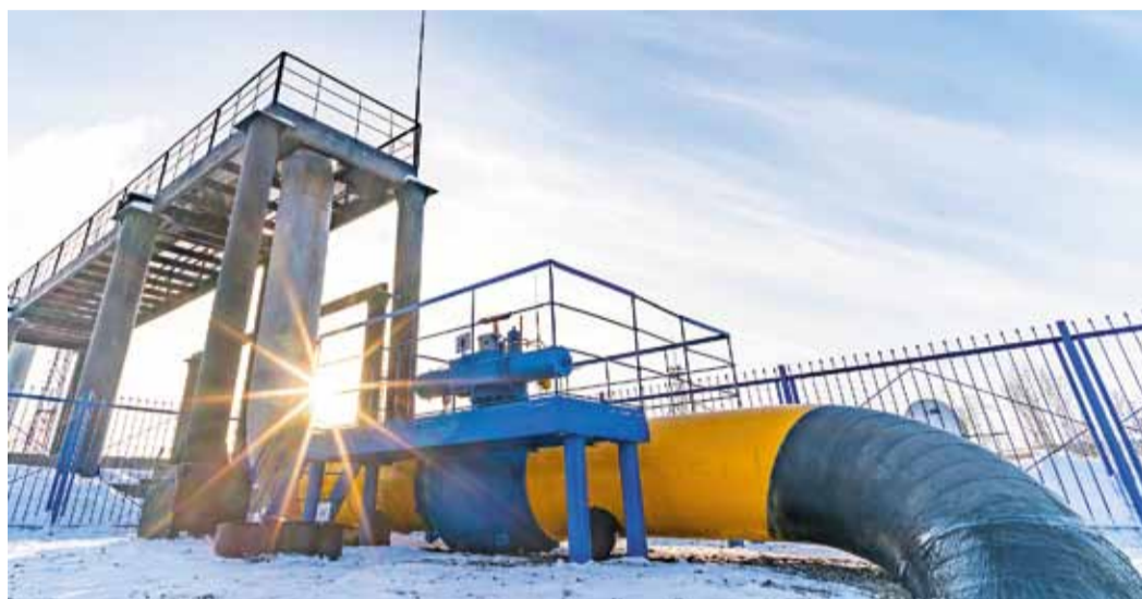
«Нулевой» километр газопровода НГПЗ – ПарABELь - Кузбасс
